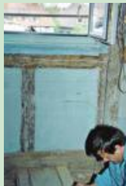
Verlegung der Messfühler
