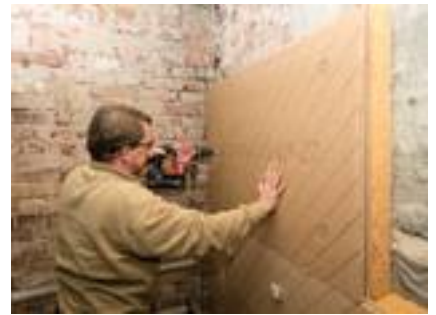
Bohren für Befestigung
