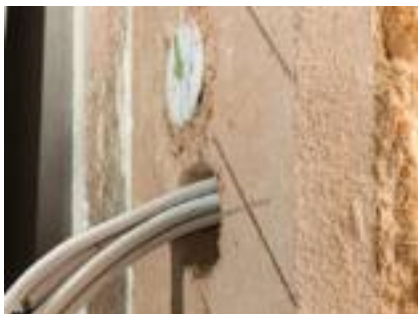
Kabel durchziehen
