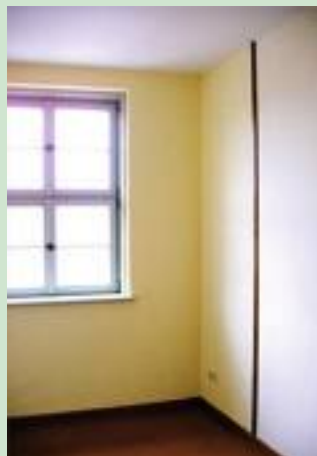
fertig sanierter Wohnraum mit Innendämmung der Außenwände
