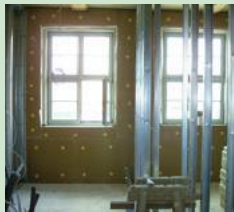
bereits montierte UdiIN® Holzfaserdämmplatten
