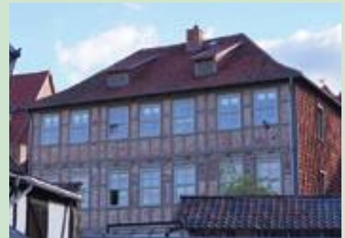
Forschungsobjekt in Quedlinburg von außen
