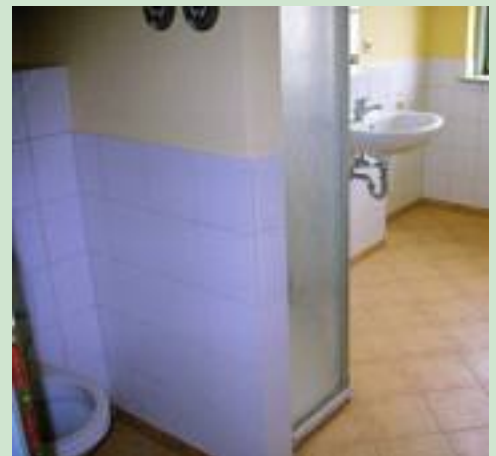
fertig saniertes Bad mit Innendämmung der Außenwände
