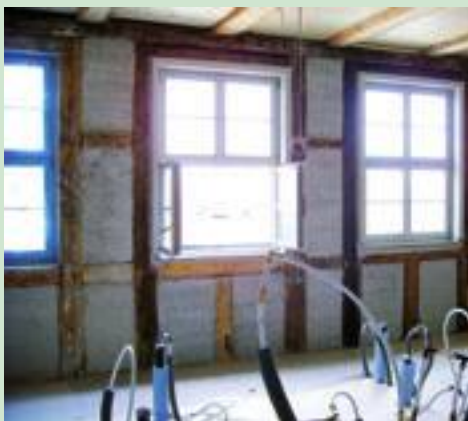
teilweise Erneuerung der Ausfachungen
