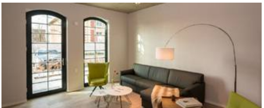
Fertige Innendämmung mit Udi Feinputz
