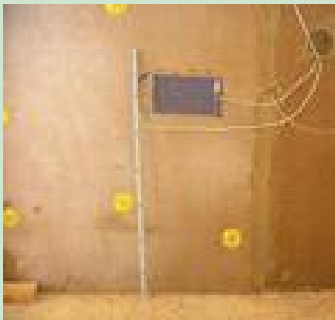
mit eingebauten Messfühlern
