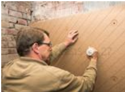
Dübel setzen
