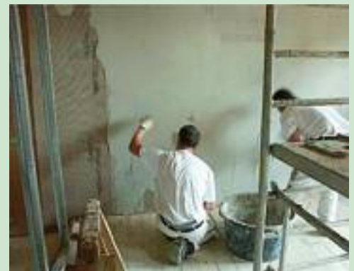
Spachtelung mit UdiMULTIGRUND® und Armierung
