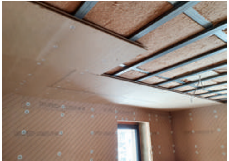
Deckenmontage auf Metallständer
