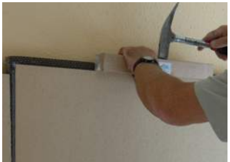
Direktmontage Wand für Schallschutz
