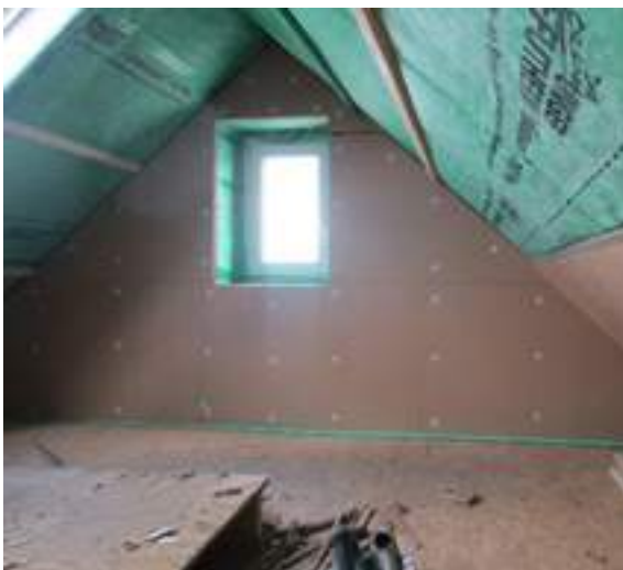
Dachausbau als Untersparrendämmung
