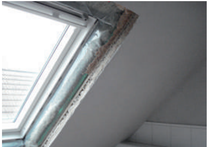
Nachträgliche Dämmung Dachschräge
