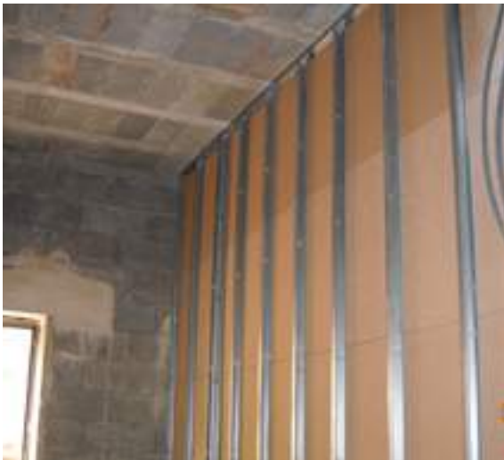
Zwischenwand Ständermontage
