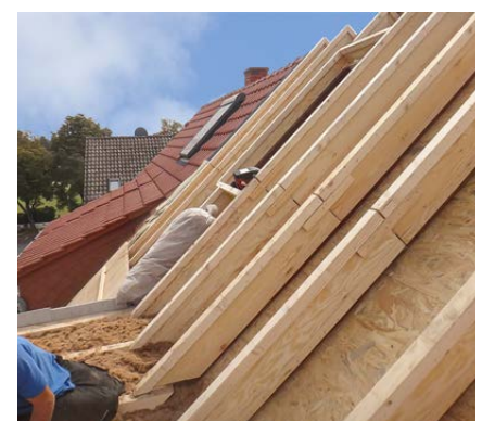
Dacherhöhung mit UE 145
